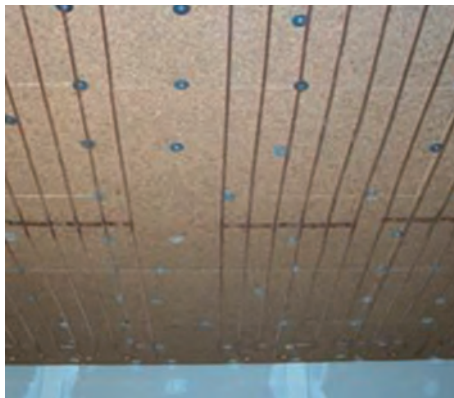
Figura a lato: Posa di pannelli radianti a soffitto
