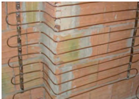
Figura sopra: posa in opera di un impianto a parete
