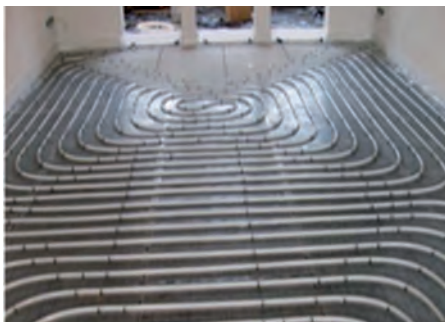
Figura sopra: posa in opera di un impianto a pavimento
